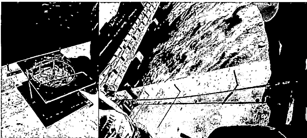
IMAGEN 14 Se ubica la plancha guía de 0.20 x 0.20 x 1/8", alineándolo al eje de todos los pedestales.
