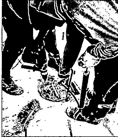
IMAGEN 01 Limpieza previa del área donde se colocará el acero de refuerzo.
