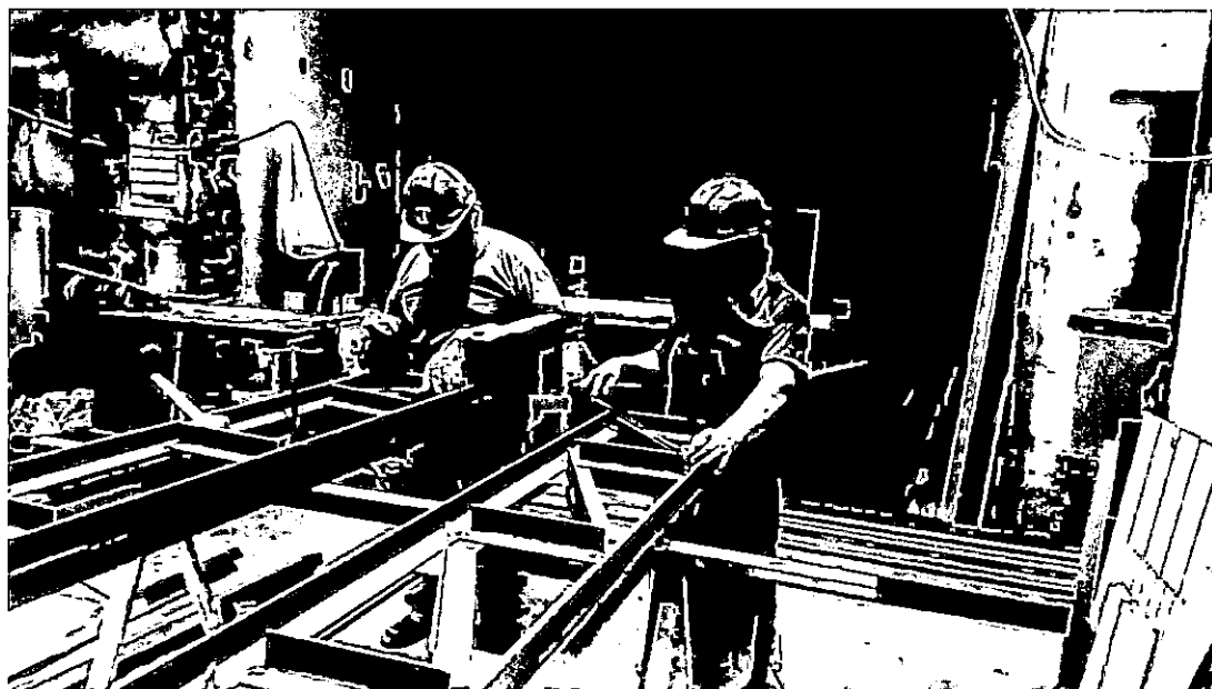
FOTO N°014 – Fabricación de vigas
