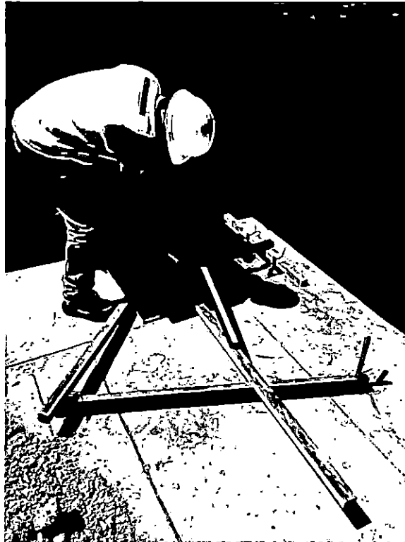
FOTO N°009 – Encofrado para Pedestales después del RNC
