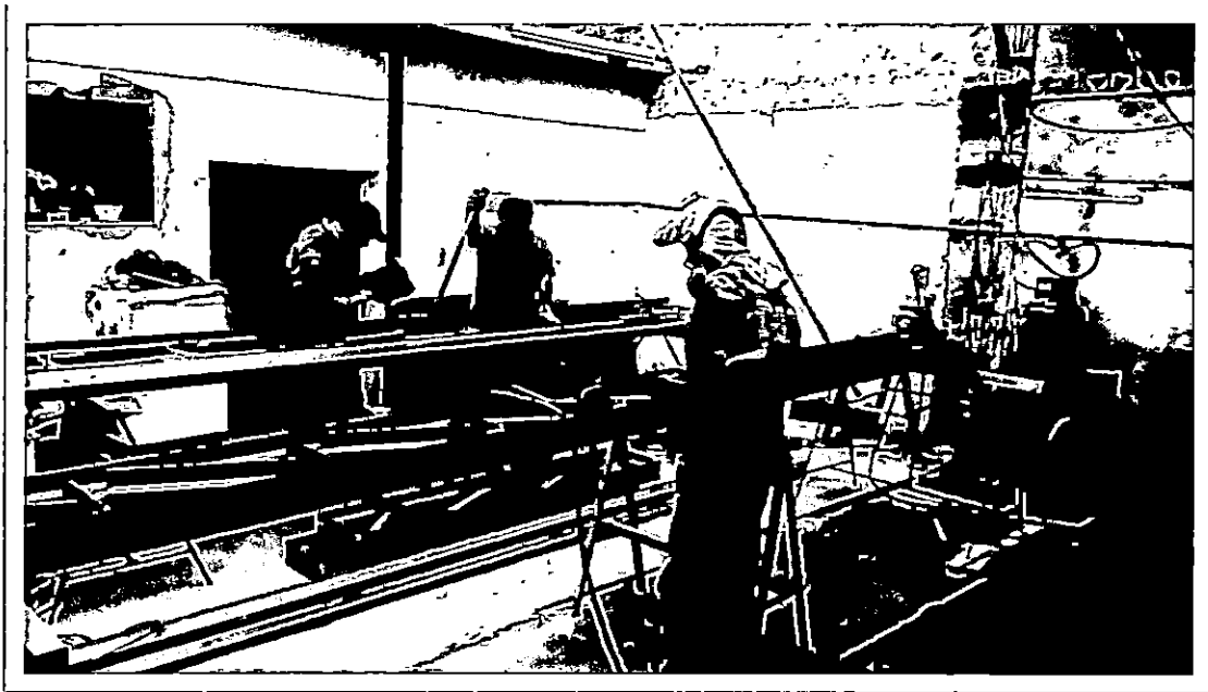
Imagen N° 10 Fabricación de vigas – Estructura Metálica
