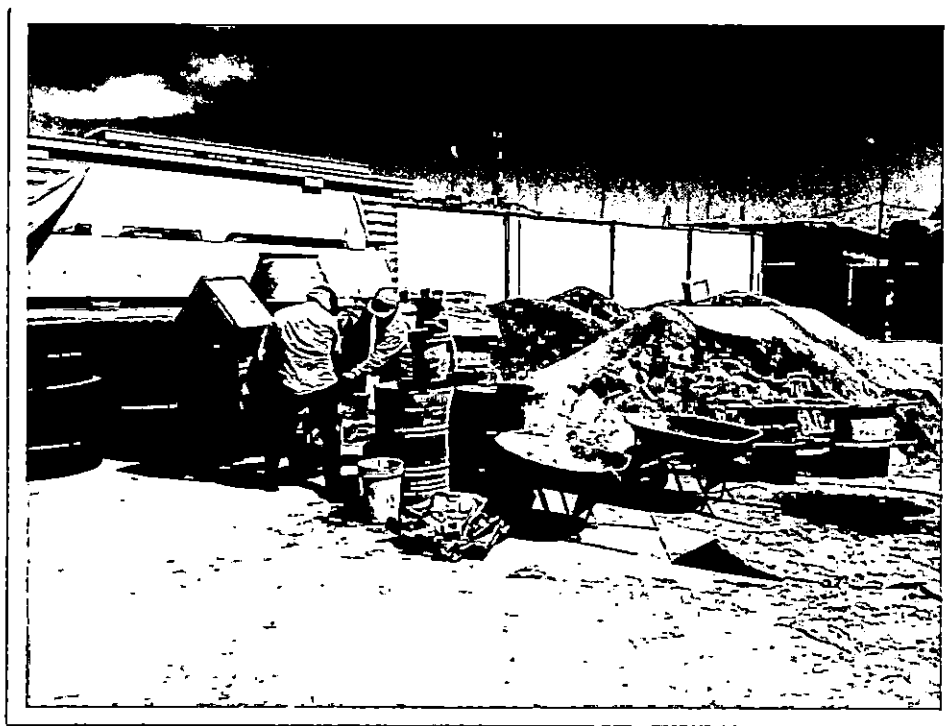
Imagen N° 2 Elaboración de concreto en obra – Pedestales
