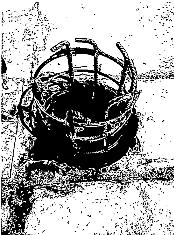
FOTO N°003 – Observaciones después de lluvias
